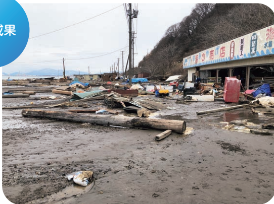
▲上越市内の調査現場の様子
